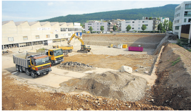
TÄGIPARK 2 Zwischen Shedhalle (links), den Wohnhäusern an der Jurastrasse und der Verzinkeerei Wettingen (rechts) wird die Grube für das neue Einkaufszentrum ausgehoben. WALTER SCHWAGER
