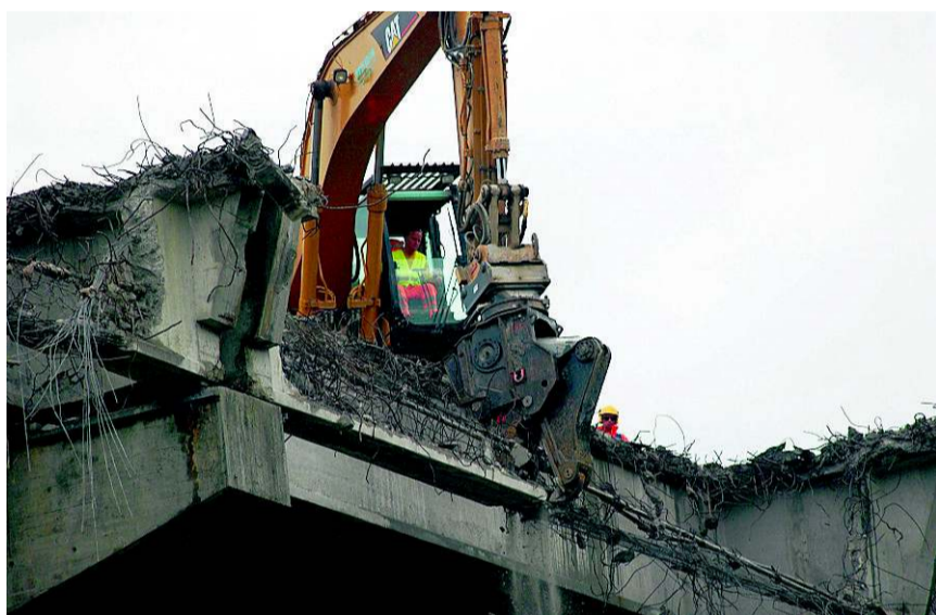
Die Arbeiten auf dem Viadukt erfordern äusserste Konzentration.
