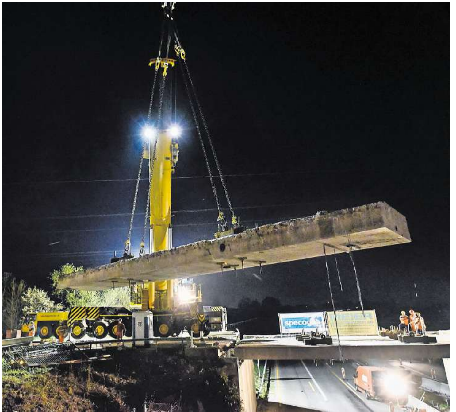
Nach langer Arbeit kann das eigentliche Brückenteil mit dem Teleskopkran zum Lagerplatz geschwenkt werden.
