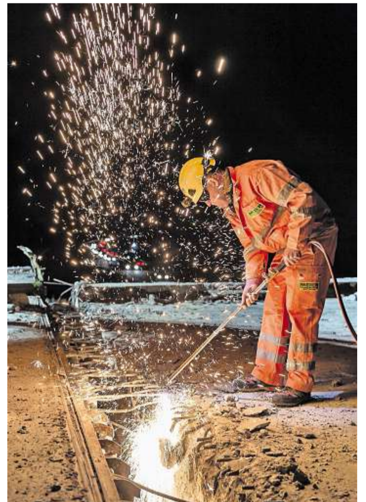
Die Betoneisen werden mit dem Schweißbrenner durchtrennt.
