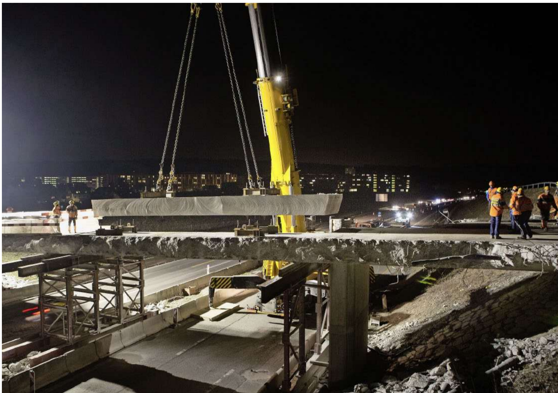
Abbruch der Horensteinbrücke beim Katzensee: Der Pneukran hebt ein 90 Tonnen schweres Betonstück weg - auf der Gegenfahrbahn rollt der Verkehr. Foto: Sabina Bobst
